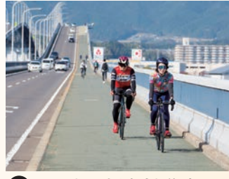
10 琵琶湖大橋有料道路
